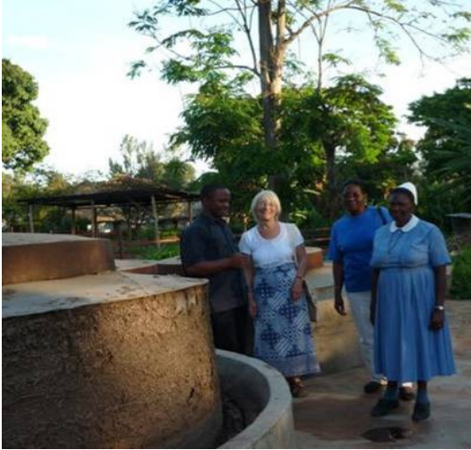
Bij de biogasinstallatie
